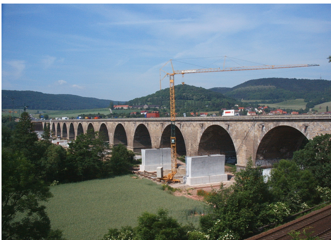
Bild 1.4 Autobahnbrücke über die Saale bei Göschwitz (Foto: Thorsten Grödel)
