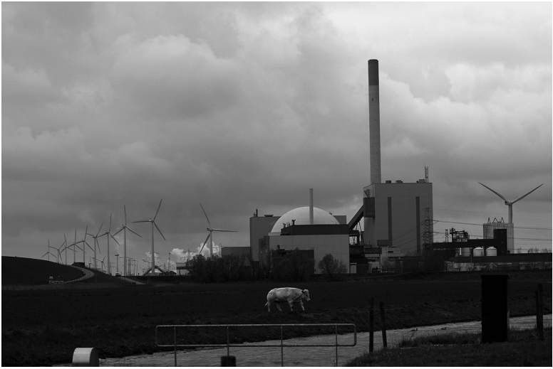
Abb. 1.14 Kernkraftwerk und Kohlekraftwerk Borssele (Niederlande), umgeben von Windenergieanlagen.
