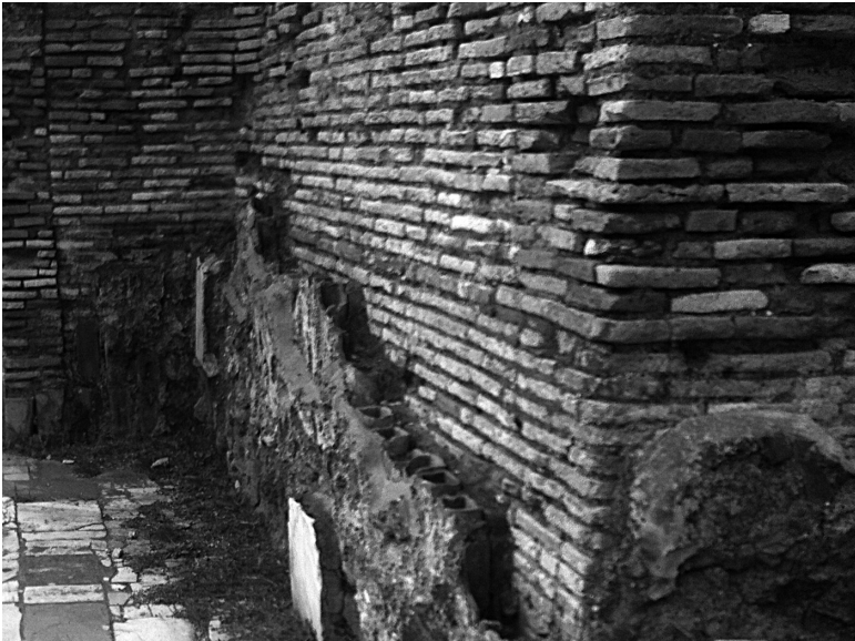
Abb. 1.2 Römischer Mauerwerk mit Kanälen der Warmluftheizung aus Thermen in Ostia Antica.
