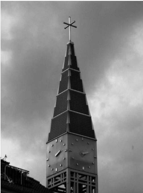
Abb. 1.15 Photovoltaische Kollektoren auf dem Turm einer Kirche in Berlin-Buch.
