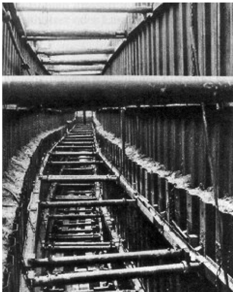
Bild 1.5 Senkrechter Grabenverbau mit gestaffelten Kanaldielen (Foto: Hoesch AG, Dortmund)
