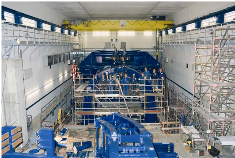
Abb. 5 Montage der Gantry im Heidelberger Ionenstrahl-Therapiezentrum HIT.
