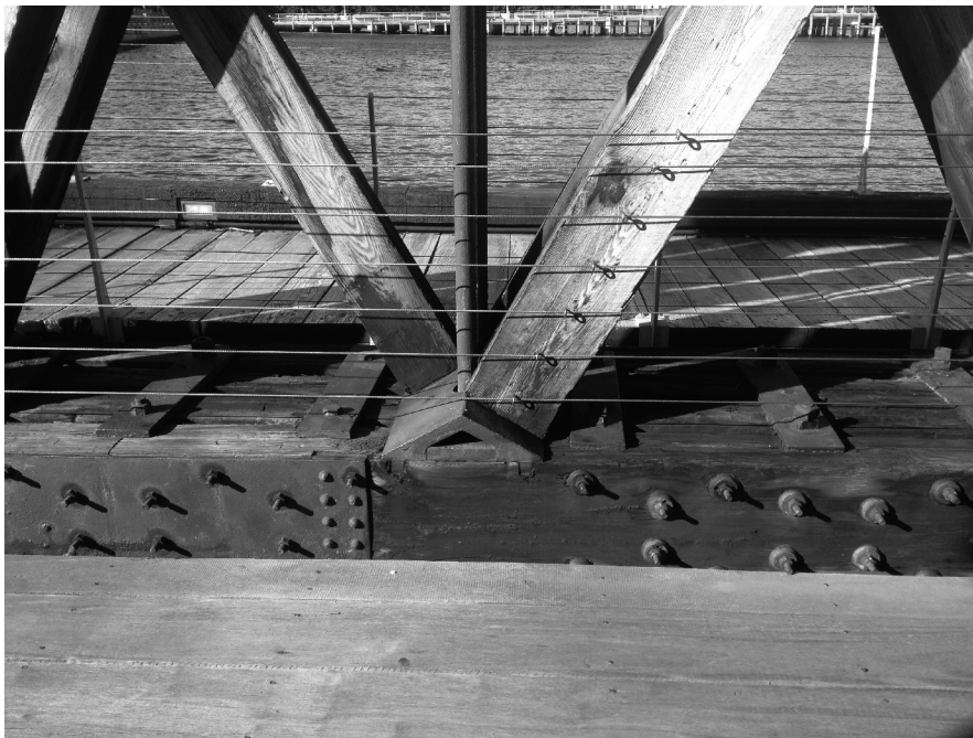
Abb. 1.7 Knoten einer Landungsbrücke am Hudson River, Howe'scher Träger (Quelle: Stefan Winter).
