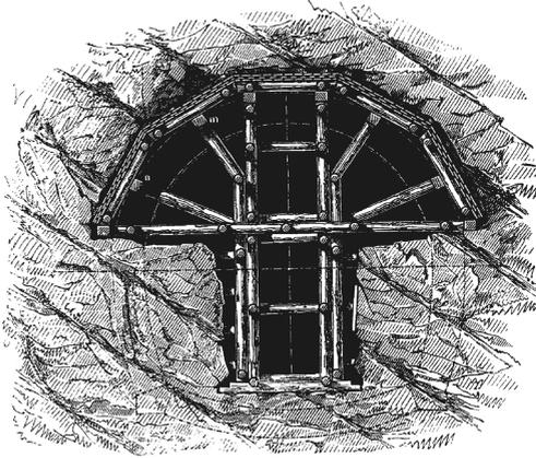
**Bild 1-4** Oesterreichische Bauweise nach Rziha (Querschnitt) [1-1]
