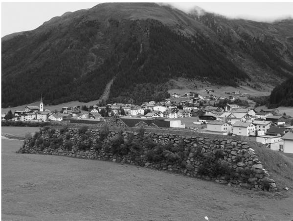
**Bild 1-4** Beispiele des baulichen Lawinenschutzes: (a); Lawinenanbruchverbauung mit Schneenetzen (© Sauermoser); (b) Lawinenauffangdämme zum Schutz der Gemeinde Galtür (Tirol) (© Rudolf-Miklau)
