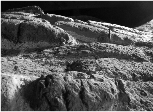
Bild 4. Zustand (Restquerschnitt teilweise nur noch etwa 5 bis 6 cm stark) des Gewölbemauerwerks (Gewölberücken) nach Abnahme des Wärmedämmmörtels und Reinigung
