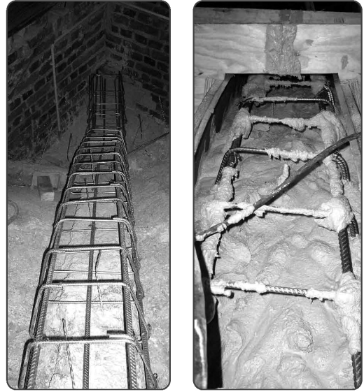
Bild 7. Einbau sogenannter Oberlastrippen mit Rückverankerung der Natursteinrippen mittels Doppel-Wendelankern [9]
