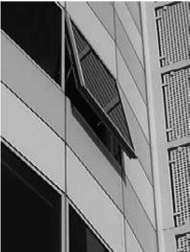
**Bild 14.** Im Falle hoher Grenzschichttemperaturen an der Fassade ungünstige Fensterlüftung
