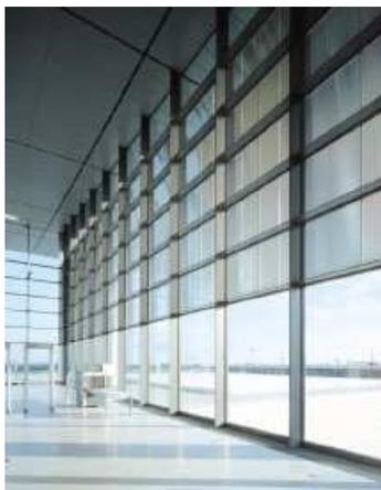
**Bild 3-5** Aerogare Luxembourg mit integriertem Sonnenschutz im oberen Bereich der Fassade, Atelier Paczowski & Fritsch, 2008
