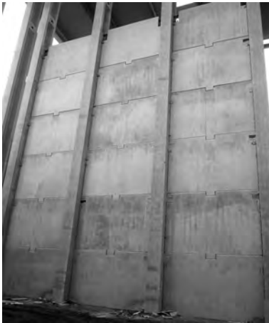
Bild 156. Kernwand mit verzahnter Horizontalfuge (Foto: Bremer AG)
