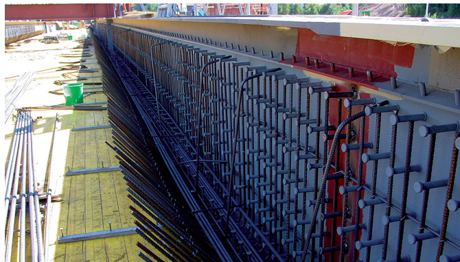
Bild 19: EÜ B6 in Halle – Anschluss der Verbundfahrbahn an die Hauptträger (Foto: Ludolf Krontal)
