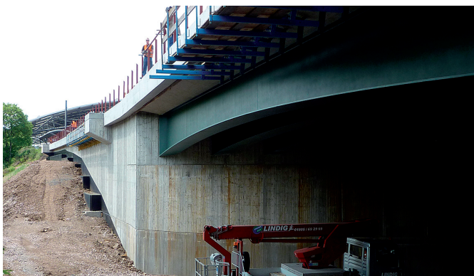
Bild 17: VFT®-Rahmenbrücke, EÜ Flutgraben im Bf Erfurt (Foto: Matthias Kühn DB Projekt Bau GmbH, Erfurt)
