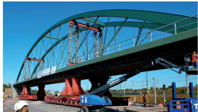
Bild 7 (re): Die Netzwerkbogenbrücke EÜ B6 in Halle wurde seitlich ca. 100 m entfernt auf einer Vorfertigungsfläche montiert und die Fahrbahn betoniert. Mit synchron fahrbaren Schwerlastmodulen wurde das fertige Bauwerk innerhalb einer Stunde von der Montagefläche in seine Endlage gebracht (Foto: Matthias Kühn DB Projekt Bau GmbH, Erfurt)
