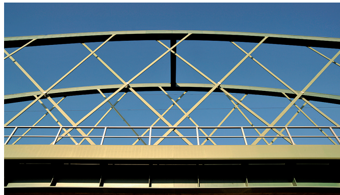
Bild 21: Netzwerk der EÜ B6 in Halle (Foto: Ludolf Krontal)
