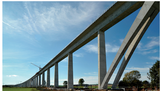
Bild 15 (re): Die Unstruttalbrücke wurde in vier je 580 m lange Haupttragwerke mit je 10 Feldern unterteilt. Der Bogen bildet den Festpunkt jedes Haupttragwerkes. Am Übergang sind Trennpfeiler mit einer Fuge in Überbau und Pfeiler angeordnet. Die Gesamtlänge der Unstruttalbrücke beträgt 2660 m und stellt in dieser Dimension eine Landmarke dar (Foto: Ludolf Krontal)
