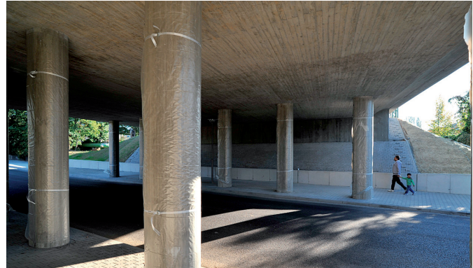
Bild 10 (li): Vergleich anprallsichere Stütze mit Lagern am Beispiel EÜ Pausaer Straße in Plauen (Foto: Ludolf Krontal)
