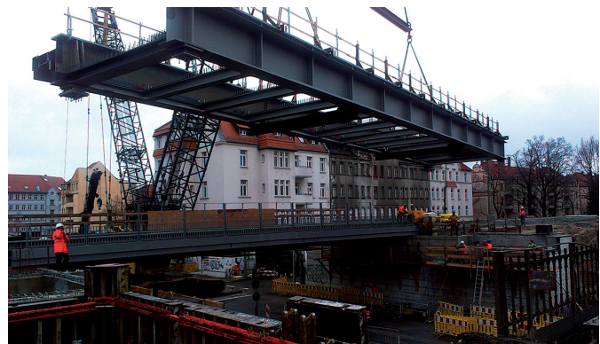
Bild 18: Stahltrögbauwerk mit Verbundfahrbahn – EÜ Papiermühlstraße in Leipzig (Foto: Karsten Jakisch, DB ProjektBau GmbH, Leipzig)
