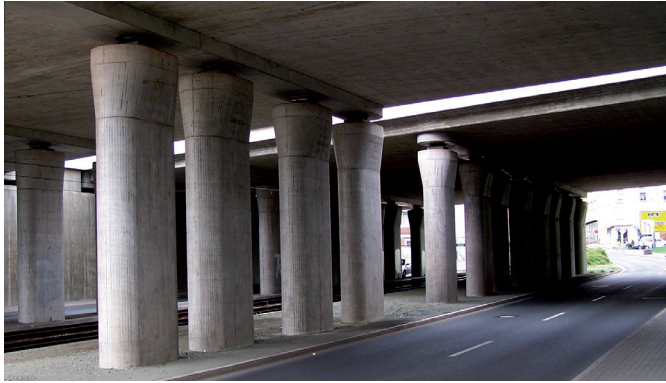
Bild 10 (li): Vergleich anprallsichere Stütze mit Lagern am Beispiel EÜ Pausaer Straße in Plauen (Foto: Ludolf Krontal)
