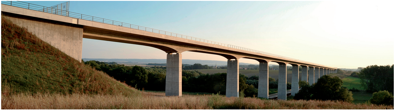
Bild 16: Der Festpunkt der 576,5 m langen semiintegralen Scherkondetalbrücke liegt am Widerlager West (ganz rechts im Bild). Elf Pfeiler wurden monolithisch mit dem Überbau verbunden. Die beiden letzten Pfeiler und das Widerlager Ost wurden vom Überbau getrennt – hier ist der Überbau auf Kalottengleislager abgesetzt (Foto: Ludolf Krontal)
