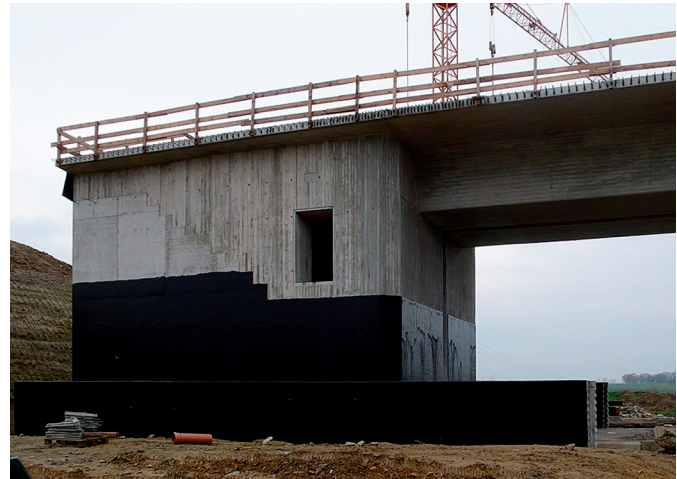
Bild 3 (re): Festpunkt der Scherkondetalbrücke Widerlager West im Bauzustand, die Gründung erfolgte mit zwei parallelen in Längsrichtung angeordneten Bohrpfahlreihen (Foto: Ludolf Krontal)
