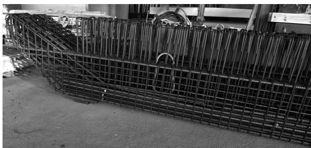
Bild 17. Bewehrung Fertigteilbalken
