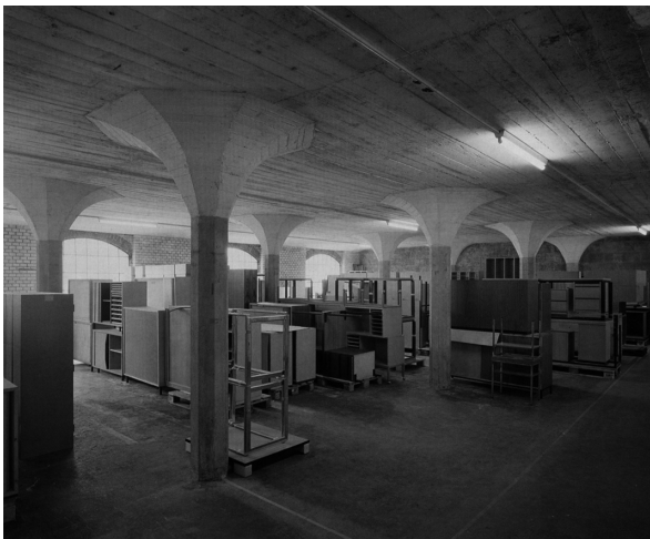
Abb. 1.12 Lagerhaus Giesshübelstraße in Zürich, Deckentragwerk von Robert Maillart (1910), aus [9].
