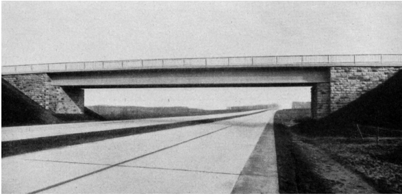
Abb. 1.18 Autobahnbrücke bei Oelde/Westf. von Wayss & Freytag (1939), aus [54].
