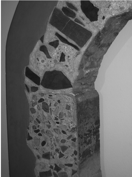
Abb. 1.1 Römische Wasserleitung, Detail.
