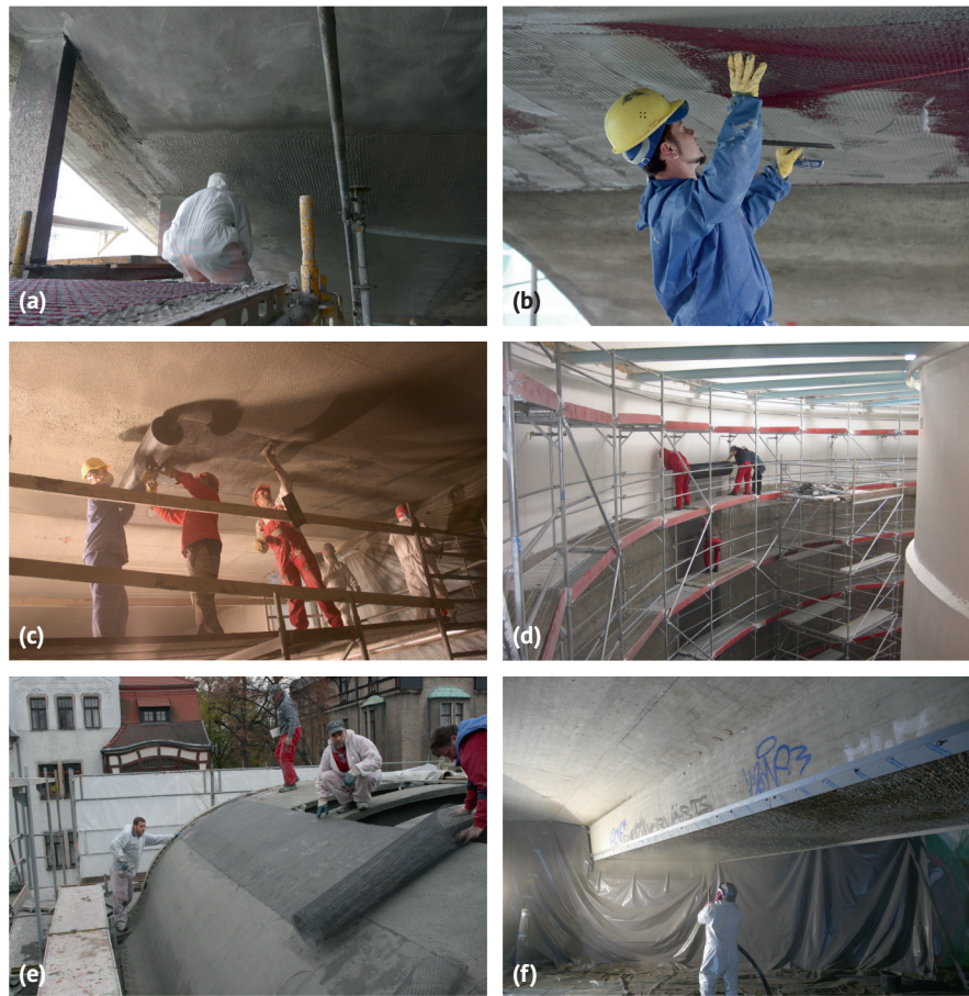
Abb. 1.14 Verstärkungsarbeiten: (a) Hyparschale in Magdeburg, (b) Bogenbrücke in Naila, (c) Geschossdecke in Prag, (d) Silo in Uelzen, (e) Tonnendach in Zwickau, (f) Autobahnbrücke über die Nidda (Quellen: (a), (f) Amer Suliman; (b) Jörg Singer; (c–e) TU Dresden).
