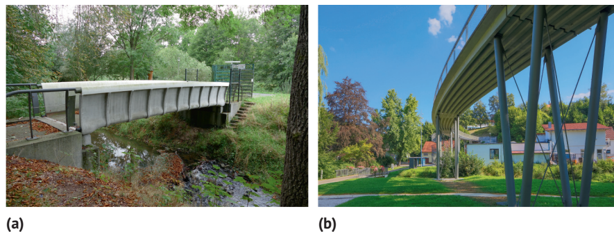
Abb. 1.12 Fußgängerbrücken mit Bewehrungen aus Glasfasern; (a) Trogbrücke in Oschatz, (b) Plattenbalkenbrücke in Albstadt (Quellen: (a) C 3 – Carbon Concrete Composite e. V., Amer Suliman; (b) Jörg Singer).
