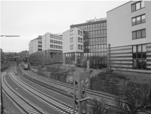
Bild 6. Gebäude Presselstraße 10 und 12
