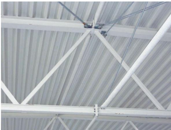
**Bild 1.16** Detail Fachwerkbinder mit Stahltrapezblechen
