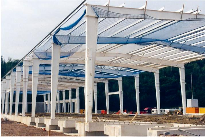
**Bild 1.6** Geschweißte Zweigelenrahmen einer Lagerhalle
