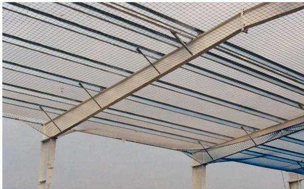
**Bild 1.7** Dachfetten, Schrägstreben und Rahmenriegel
