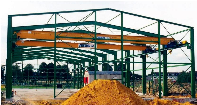
**Bild 1.2** Giebelwandkonstruktion
