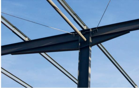
**Bild 1.12** Mittelstütze mit Rahmenecken
