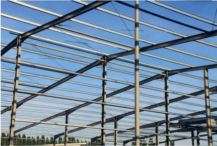
**Bild 1.9** Rahmenkonstruktion und Dachpfetten
