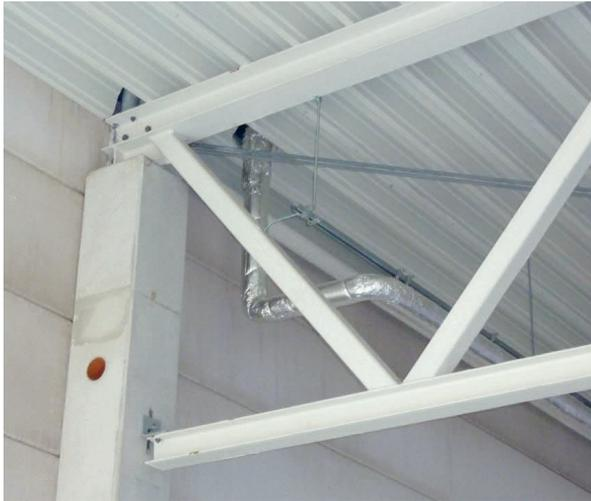
**Bild 1.15** Auflagerdetail eines Fachwerkbinders
