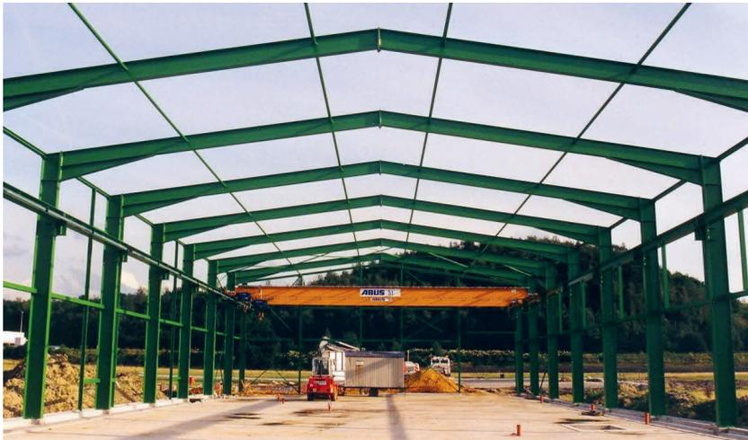
**Bild 1.1** Zweigelenkrahmen einer Fertigungshalle aus Walzprofilen
