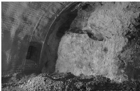
Bild 12. Sicherung des Einstiegs zur Karsthöhle 3, Zwischentunnelhöhle
