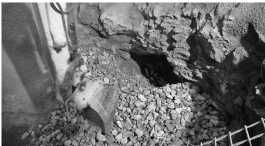
Bild 15. Verfüllen mit Grobschlag
