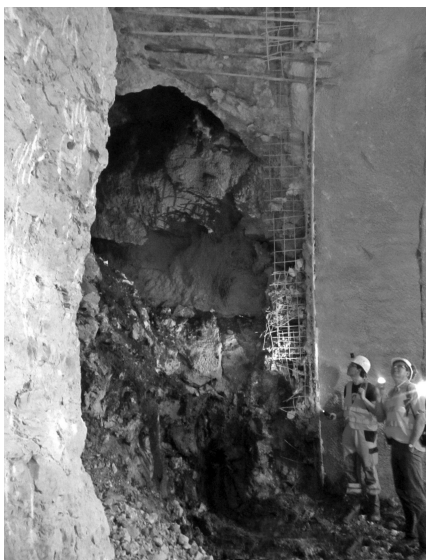
Bild 9. Antreffen der Karsthöhle 3, Zwischentunnelhöhle
