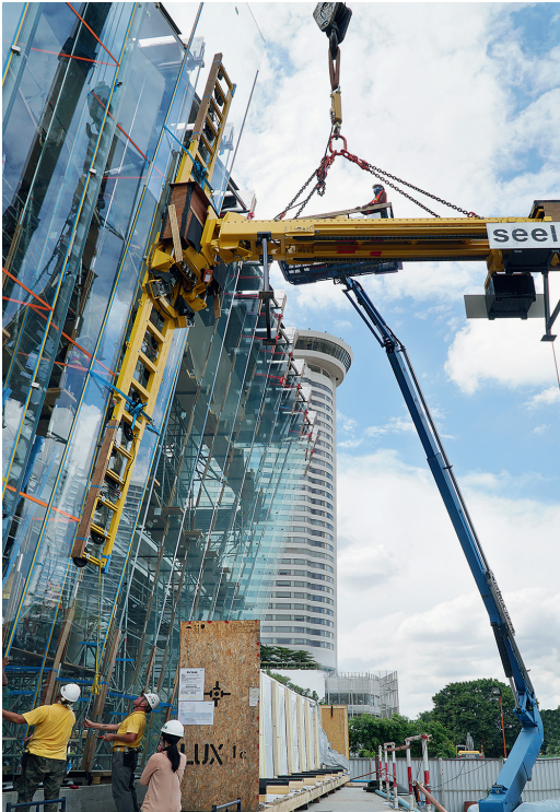
Bild 9 Montage der Glaspaneele: Die speziell angefertigte Sauganlage dreht das Glas in die geforderte Geometrie zum Einbau in die Fassade ein © seele
