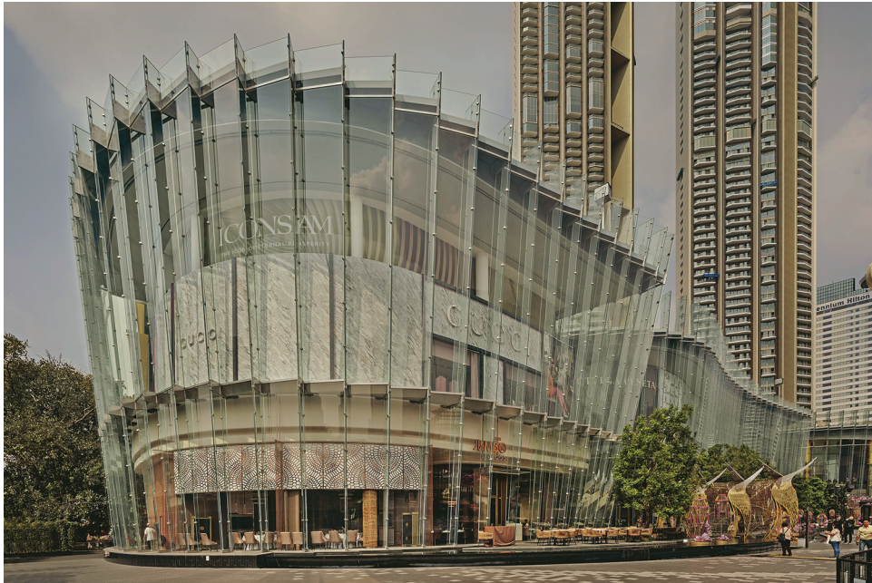
Bild 10 Pionierarbeit von seele: Die hängende Ganzglasfassade erstreckt sich über drei Bereiche (LUX1–3), ragt drei Stockwerke in die Höhe und ist mit ihrer schrägen, nach außen fallenden Geometrie wahrlich ein Meisterwerk © seele/Andreas Keller
