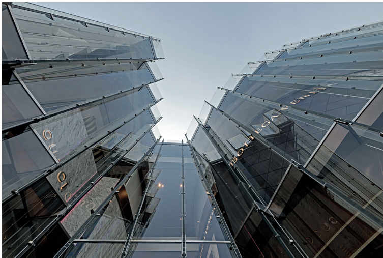
Bild 3 Detail-ausschnitt der Ganzglasfassade © seele/ Andreas Keller
