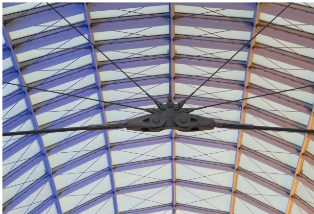
Bild 4 Radial verlaufende Seilkonfiguration zur Aussteifung (© schlaich bergemann partner)
