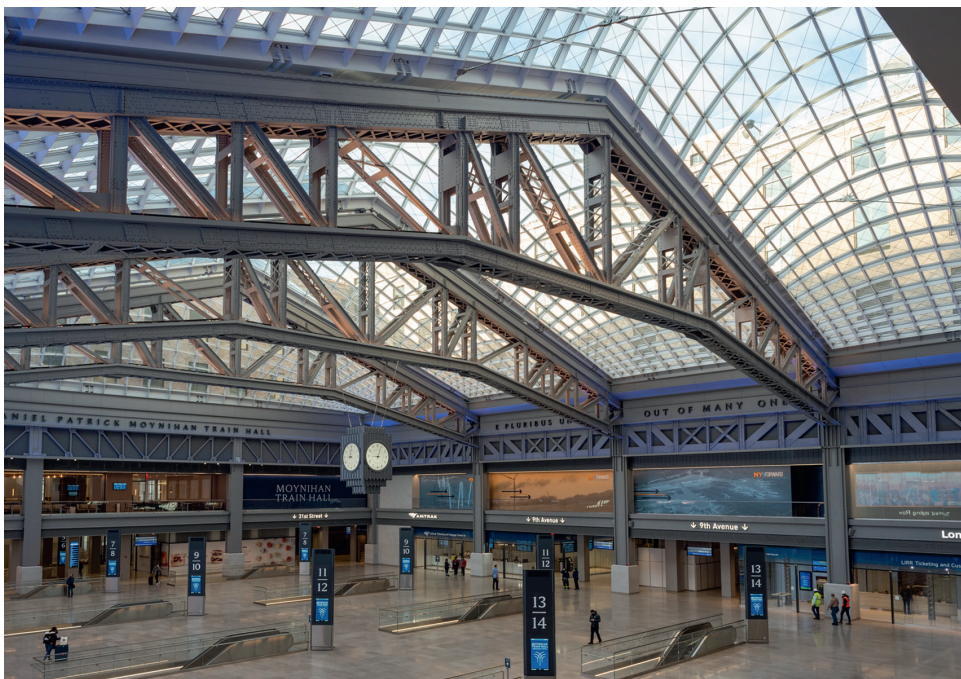
Bild 3 Überdachung der Hauptthalle (© S. Hollinger, schlaich bergemann partner)
