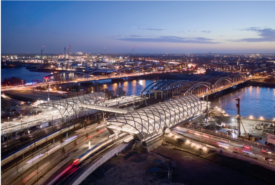
Bild 5 S-Bahn- und U-Bahn-Station Elbbrücken (© M. Bredt, Bredt Fotografie)
