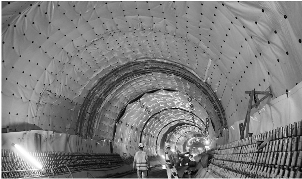
Bild 1. Einsatz des Abdichtungssystems mit drei Komponenten: geosynthetische Tondichtungsbahn (Bentonitmatte), Kunststoffdichtungsbahn, Blockhinterlegung und Betoninnenschale
