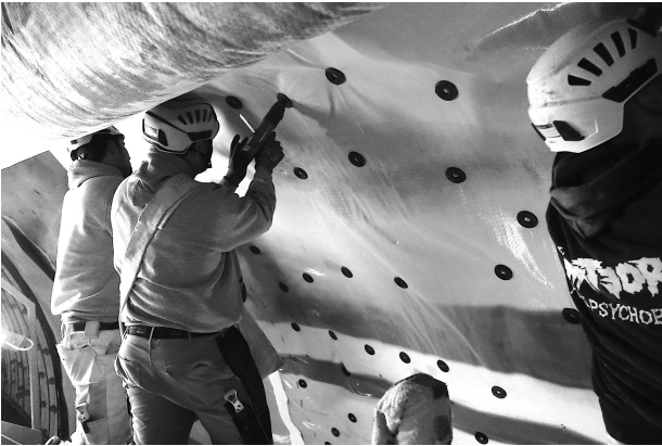
Bild 11. Punktuelle Befestigung der Bentonitmatten nach Raster in Gewölbe, Ulme und Sohle
