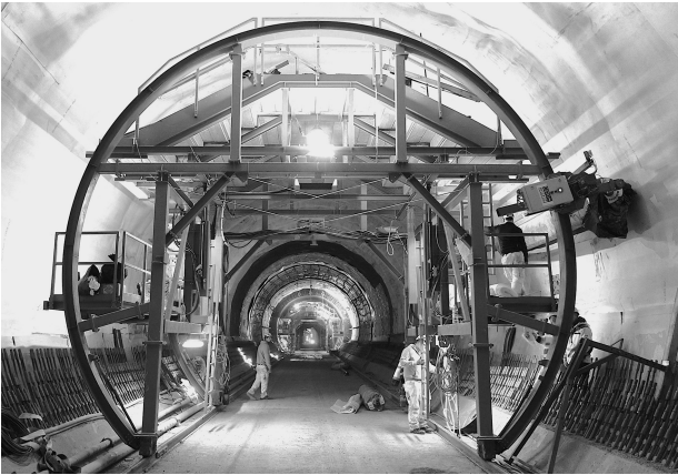
Bild 8. Doppellagige Druckwasserabdichtung als Mehrkomponentensystem mit Bentonitmatten
