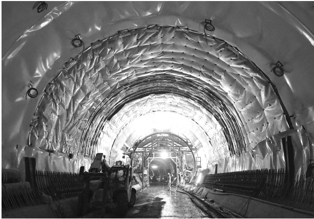
Bild 4. Verpress- und Entlüftungsleitungen im außenliegenden Fugenband
