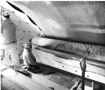
Bild 10. Installation mit einer maschinell geführten Verlege-traverse aufgrund des hohen spezifischen Eigengewichts der Bentonitmatten
