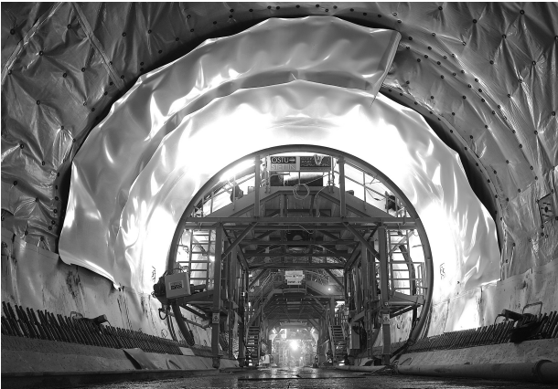
Bild 7. Im Gewölbe eingebaute Bentonitmatte
