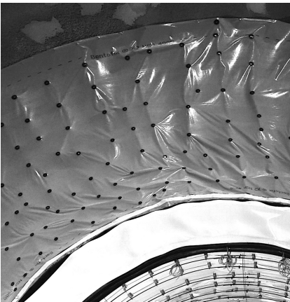
Bild 12. Temporäre Befestigung der nachfolgenden KDB an den Befestigungspunkten der GTD
