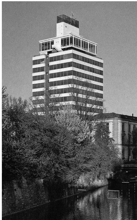
Bild 1.12 Gebäude „zur Schanze“ mit Aufstockung in Zürich.
