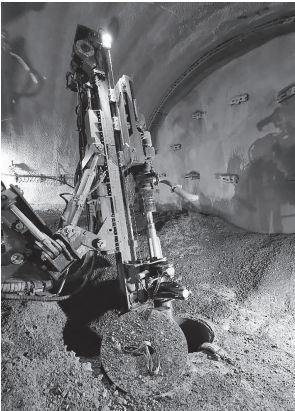
Bild 12. Bohren eines Vertikalfilterbrunnens
