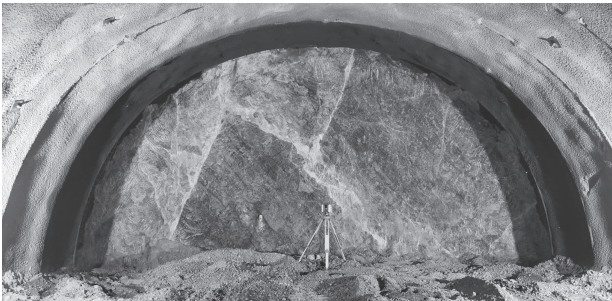
Bild 6. Ortsbrustfoto bei Tunnelmeter 3176,5 im Hauptdolomit mit weißen Kakiritbändern
