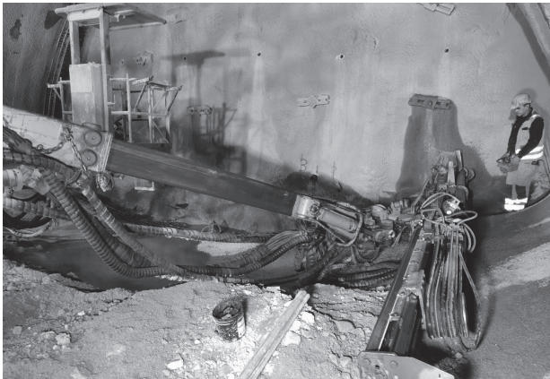
Bild 13. Steigende Drainagebohrung im Querschnitt mit dem Vortriebsbohrwagen
