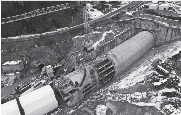
Bild 19. Voreinschnitt Süd mit bereits hergestellter offener Bauweise vor der Hinterfüllung
