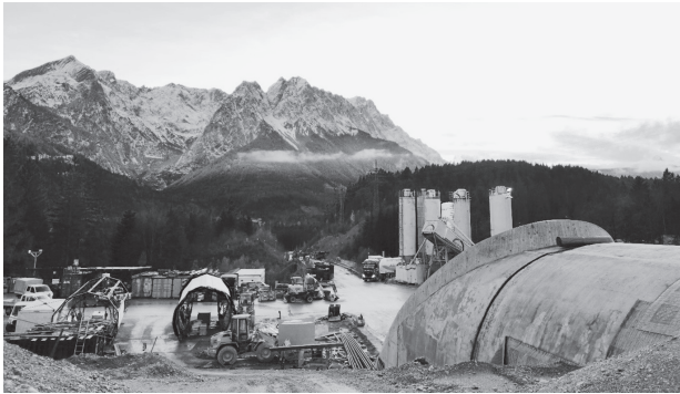
Bild 30. Südportal mit Wettersteinmassiv
