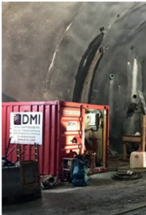
Brenner-Basistunnel H52 – Gebirgsinjektion (bis 100 bar Wasserdruck)
