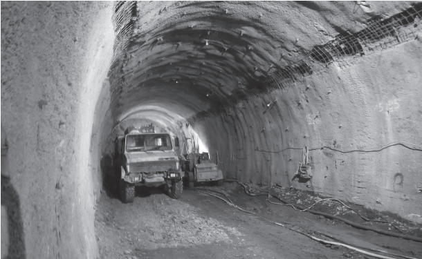
Bild 21. Schlitze in der Spritzbetonschale beim Vortrieb in der Kramerüberschiebung
