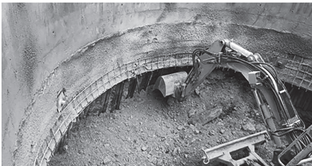
Bild 23. Abteufen im Lockergestein im Schutz der Spunddielen
