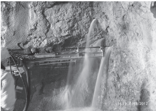
Bild 20. Vortrieb Erkundungsstollen im Hauptdolomit
