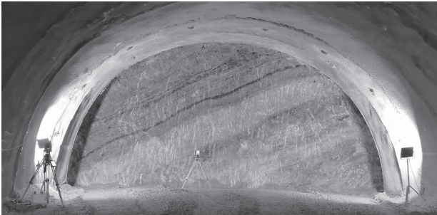
Bild 5. Ortsbrustfoto bei Tunnelmeter 2877,6 im gut geschichteten Hauptdolomit
