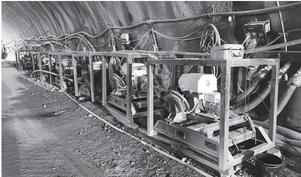
Bild 11. Membrankolbenpumpen beim Vortrieb des Haupttunnels
