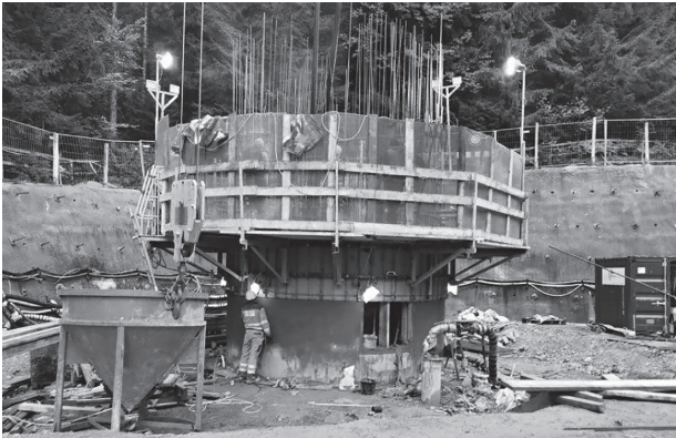
Bild 27. Gleitschalung zur Herstellung des Abluftkamins
