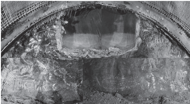
Bild 24. Durchschlag vom Kalottenvortrieb der Kaverne in den Schacht
