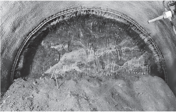
Bild 15. Ortsbrust der Kalotte im Bergsturz mit Ausbruchmaterial
