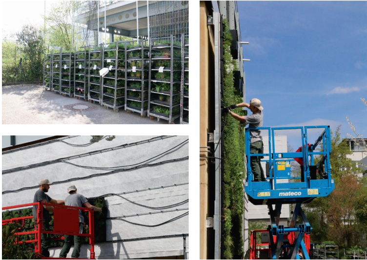
Bild 33. Fotografische Detailaufnahmen zur Installation der weiterentwickelten biodiversitätsfördernden Grünfassade
