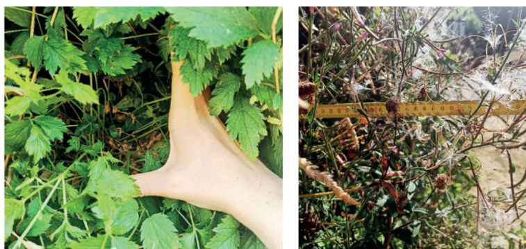
Bild 9. Fotografische Detailaufnahme der Pflanzschicht an der UNA-TERRA-Fassade. Durch die Anpassung der Pflanzen entlang ihrer Umweltpräferenzen haben sich zwei Pflanzschichtungen ausgebildet [50].
