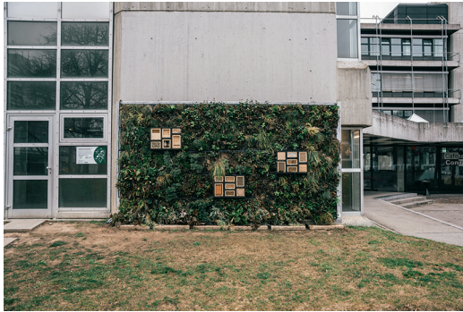
Bild 5. Fotografische Aufnahme der UNA-TERRA-Fassade unmittelbar nach der Installation im Februar 2022
