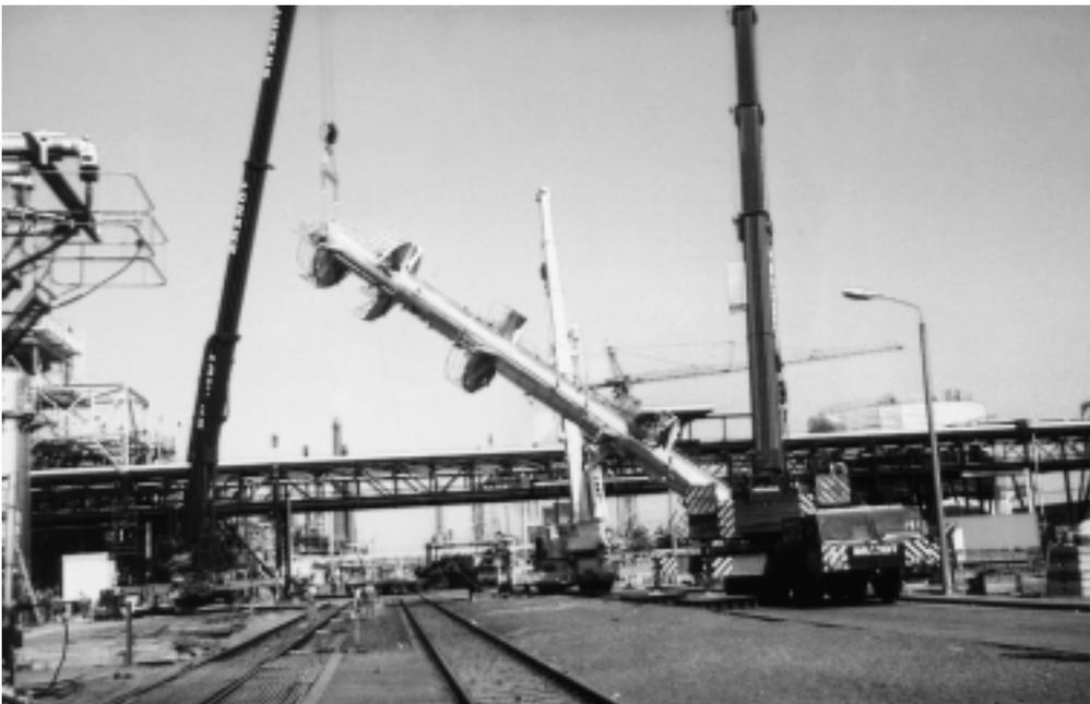
**Abb. 5.8** Einkranmontage einer Kolonne
