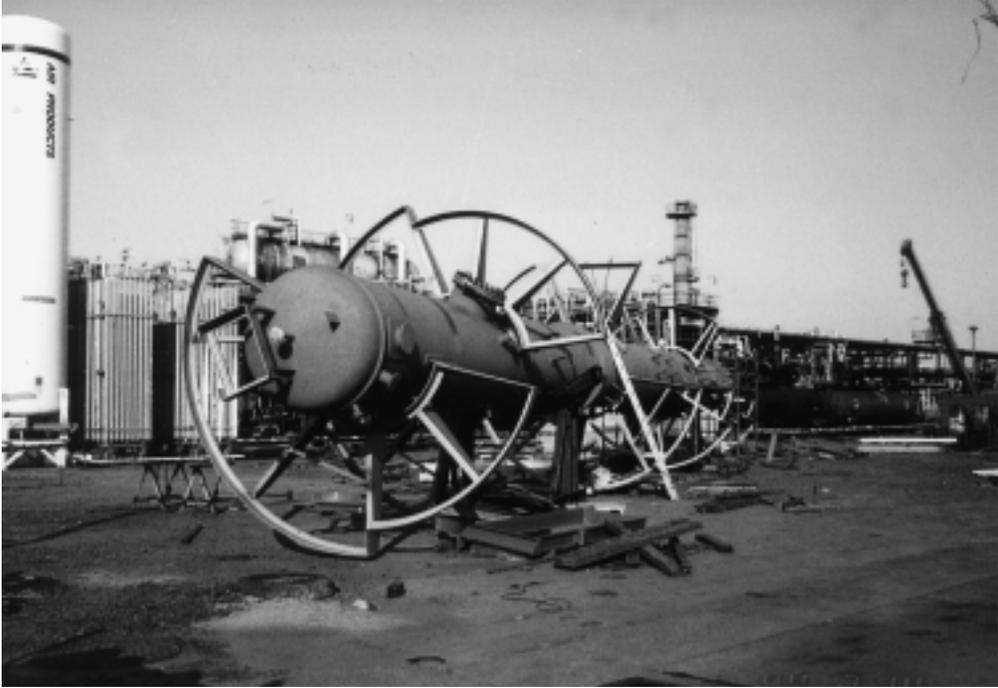
**Abb. 5.2** Baustellenkomplettierung einer Kolonne
