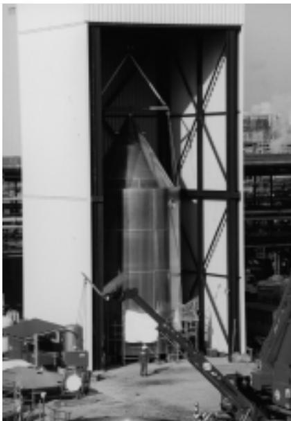
**Abb. 5.6** Montagebereich, Vorteil: Konstanz der Arbeitsbühne (Werksfoto Zeppelin Silo- und Apparatechnik GmbH Friedrichshafen)
