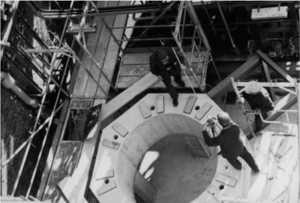
**Abb. 5.13** Vorbereitung des Kolonnenfundaments
