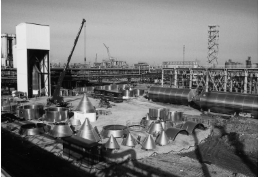
**Abb. 5.5** Temporärer Montageturm für die Vormontage von Silos (Werksfoto Zeppelin Silo- und Apparatechnik GmbH Friedrichshafen)
