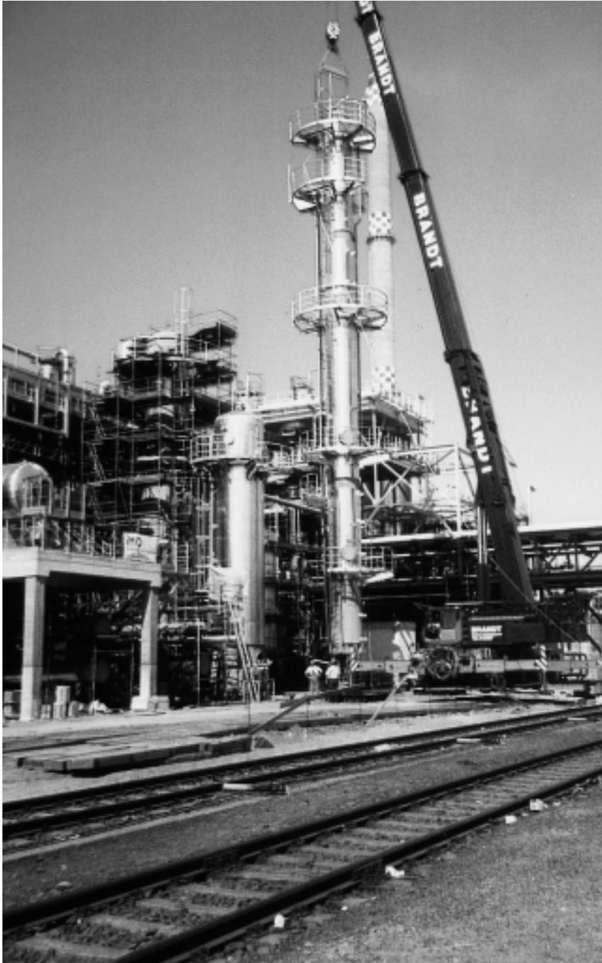
**Abb. 5.1** Einschwenken einer komplettierten Kolonne
