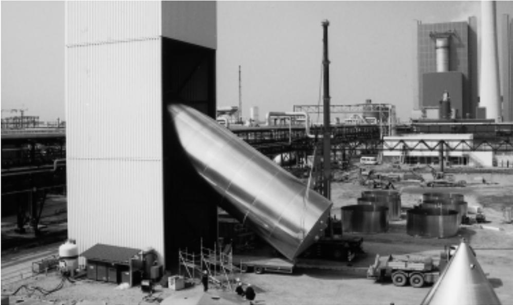
**Abb. 5.7** Ausfahren des kompletten Silos aus dem Montage-
