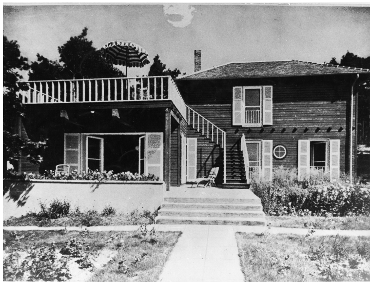
Abb. 1.12: Ansicht des Sommerhauses
