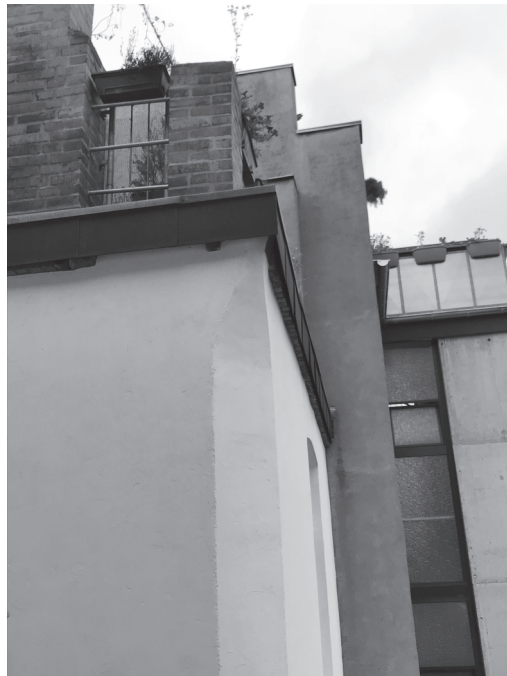
Abbildung 1.2: Wand von außen (Foto: keine Nennung gewünscht)
