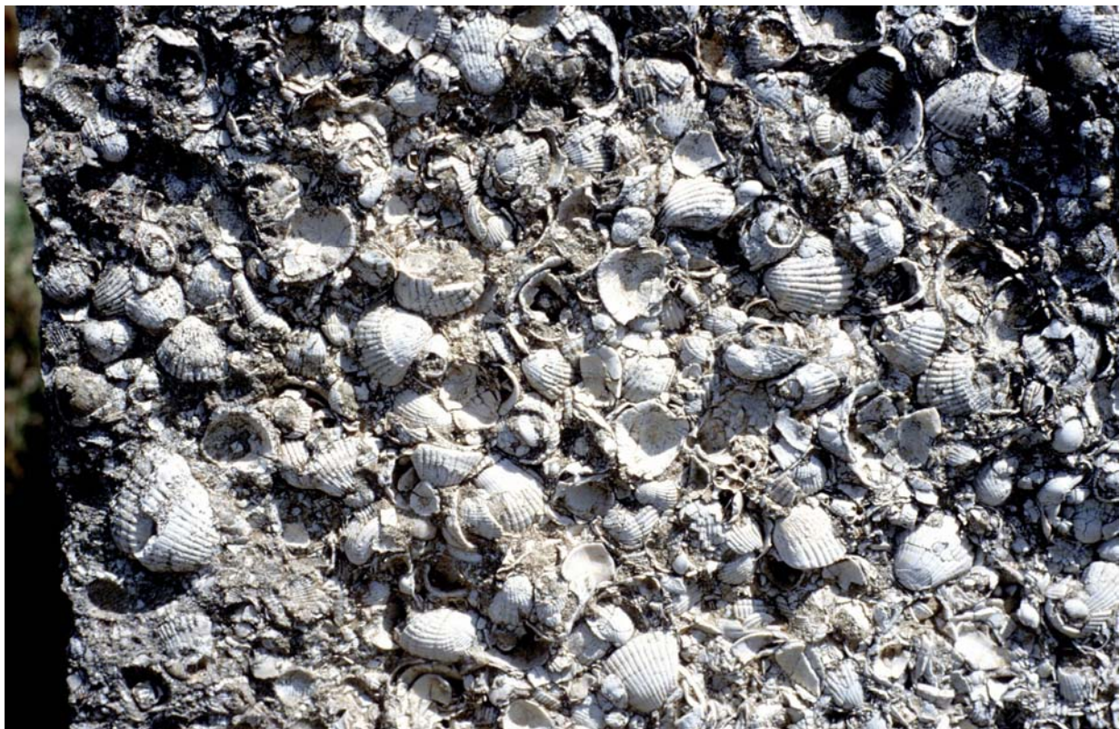
Bild 4.1.1 I: verwitternder Baustein aus Muschelkalk am Zeustempel in Olympia, Griechenland, Juni 1984
