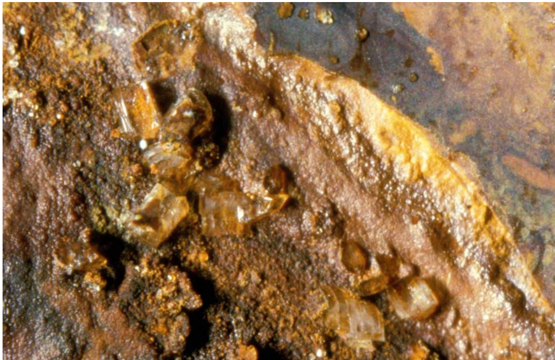
Bild 4.1.4.4 A: Barytkristalle in einer Trinkwasserleitung DN 800, Juli 1980, 1,7 x 2,5 mm
