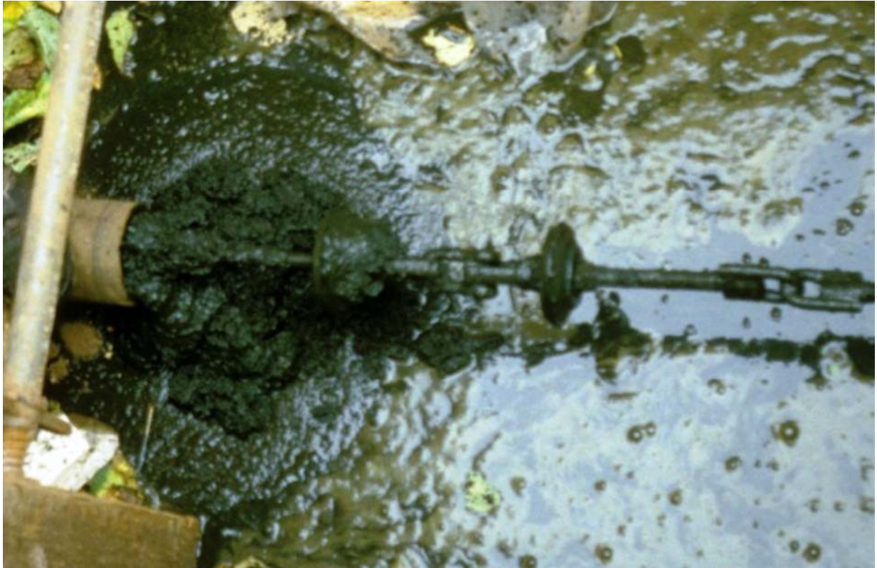
Bild 4.3.1 J: Rohrreinigung Hannover, Graugussleitung DN 100, 1985
