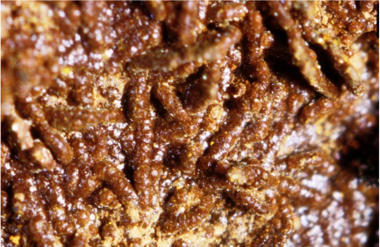
Bild 4.3.1 F: Sideritkruste in einer Graugussleitung, Hannover, DN 400, 1979, 1,7 x 2,5 mm
