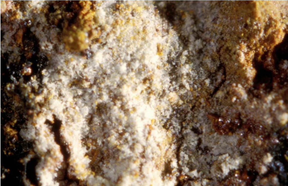
Bild 5.3.1 H: Ablagerung in einer Trinkwasserleitung DN 500, 1979, 1,7 x 2,5 mm
