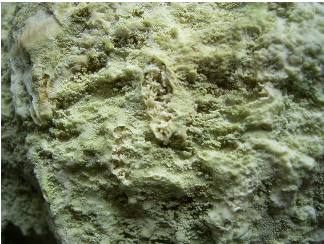
Bilder 7 L und M: Calcitabscheidung an einem Tauchfühler, der als Kathode einer Fremdstrom-Korrosionsschutzanlage geschaltet war, August 1995
