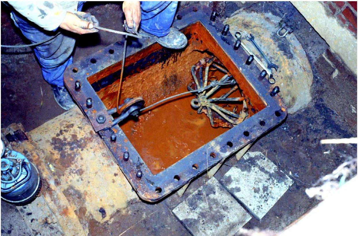
Bild 4.3.1 P: Reinigungskasten an einer verockerten Rohwasserleitung im Wassergewinnungsgebiet Fuhrberger Feld, 1972
