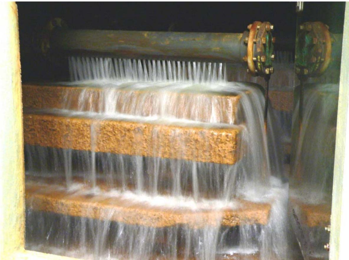
Bilder 4.3.1 C und D: Belüftungsstufe (mit und ohne Blitz).
