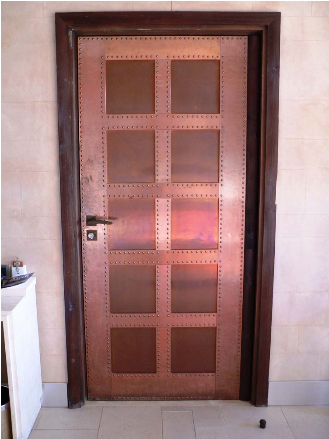
Bild 5.3.11 O: mit Kupferblech beschlagene Türe, Innenseite, Juni 2006
