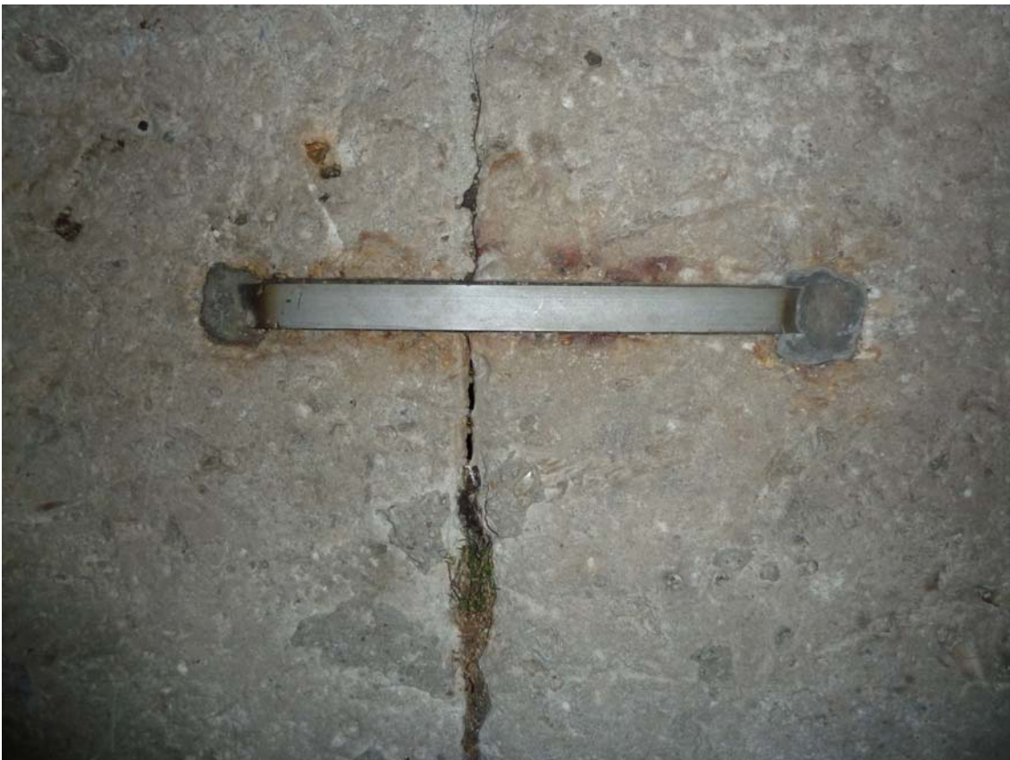
Bild 5.3.4 O: Stahlklammer an einer Kaimauer (Alter Stadthafen von Dubrovnik)
