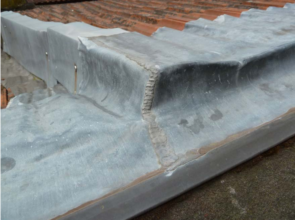
5.3.4 N Blei: Dach in der Altstadt von Bamberg (2016)
