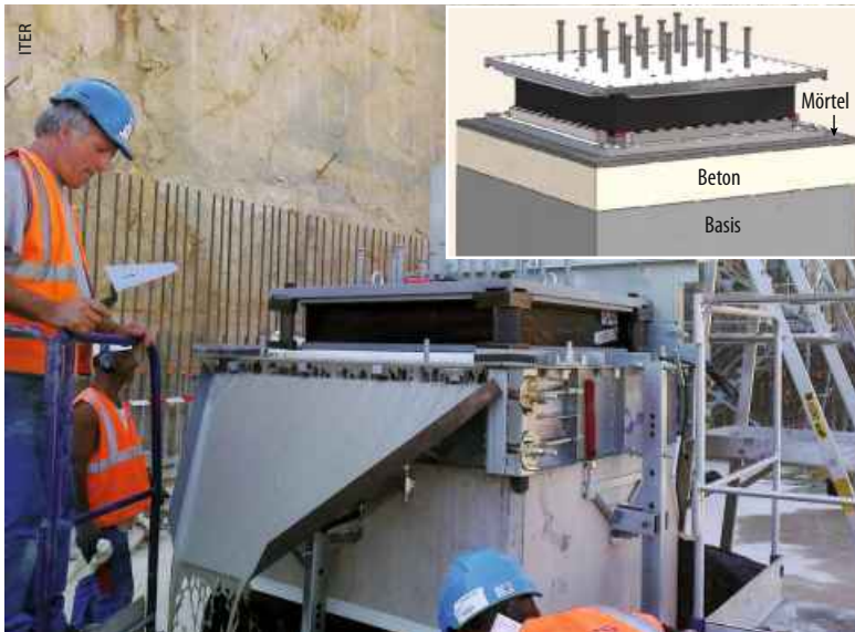
Abb. 1 Ein besonderes Verfahren garantiert, dass keinerlei Lufteinschlüsse im Mörtel zwischen Metallplatte und Beton-
