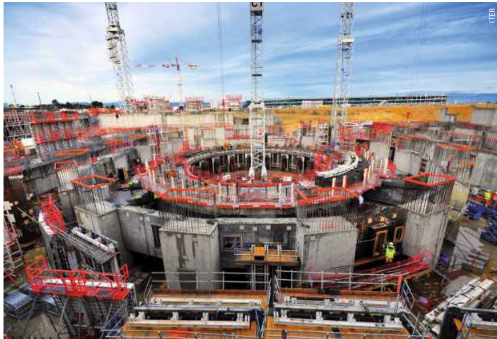
Im Zentrum der Baustelle von ITER wächst die Betonhülle in die Höhe, die später das Vakuumgefäß
