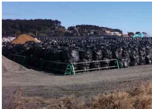
In schwarzen Säcken, die in mehreren Lagen übereinander gestapelt werden, lagert kontaminierter Boden am Wegesrand.
