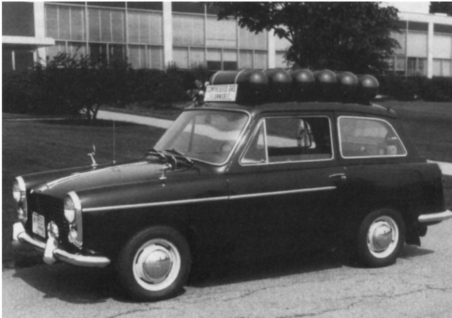
Abbildung 4.2: Ein Hauch von Nostalgie: das erste Brennstoffzellen-Auto auf öffentlichen Straßen.
